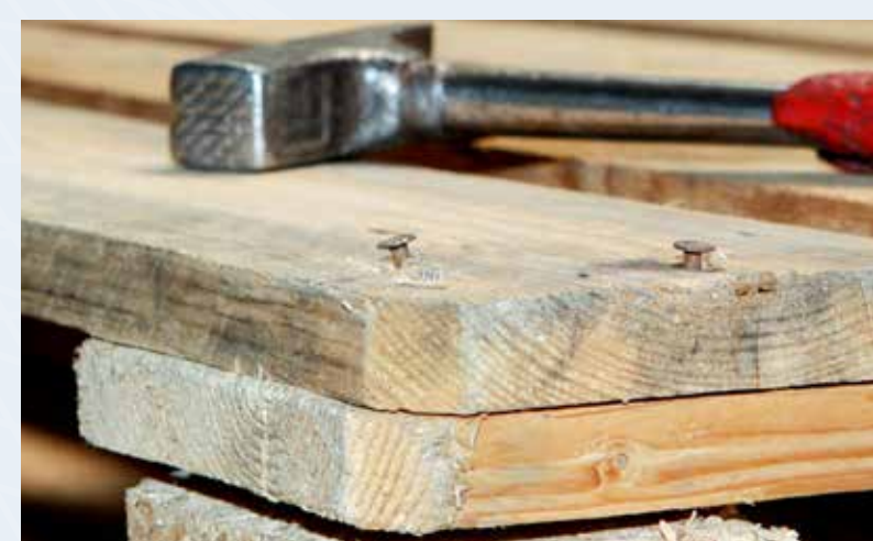
Einschlagen herausstehender Befestigungselemente
